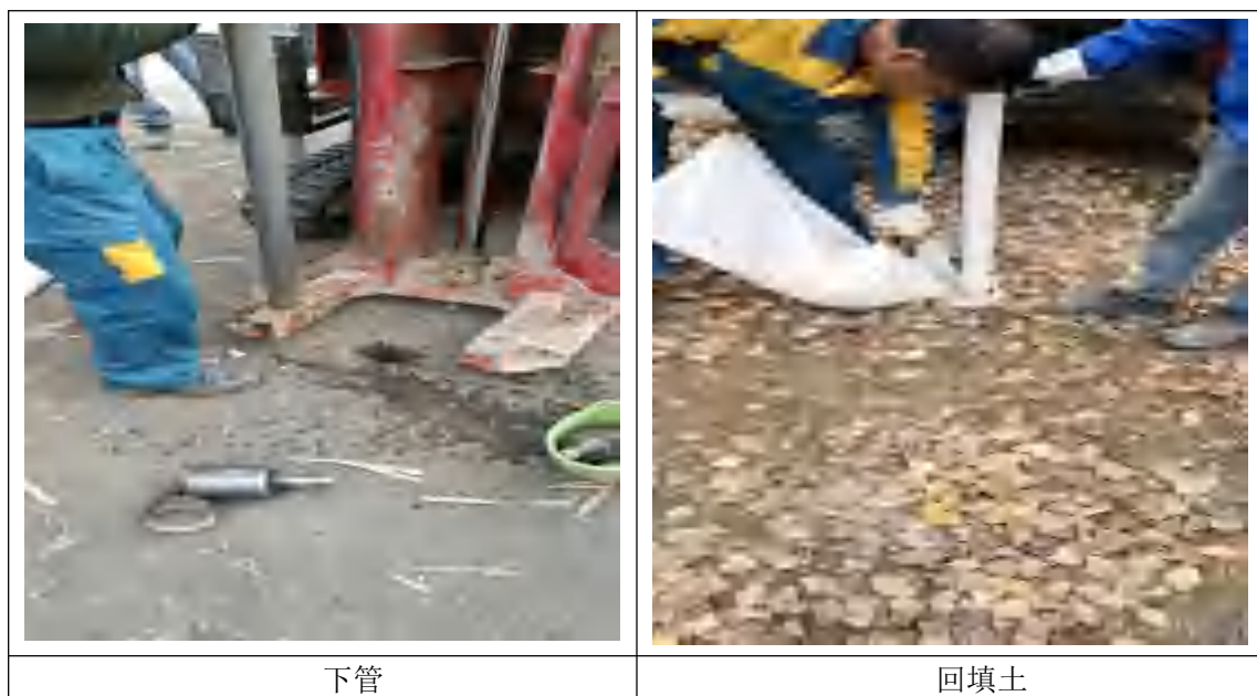
图 5-2 现场安装监测井
