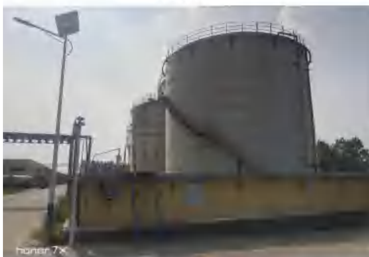
乙醇储罐区及围堰
